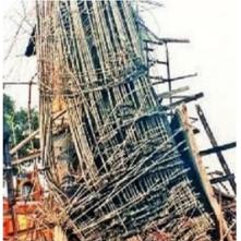
चंद्रपुर. चंद्रपुर शहर समिपस्थ वर्धा नदी पर पुल का निर्माण कार्य चल रहा है. पिलर का निर्माण कार्य चल रहा था, तभी पुल का पिलर ढह गया. इस हादसे में कुछ कर्मचारी घायल हो गए हैं. खबर है कि उन्हें अस्पताल में भर्ती कराया गया है.
